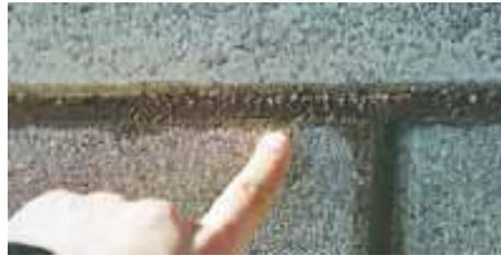
On racle l'excédent de mortier avec la truelle et quand le mortier est encore mou, la prise pas encore commencée, on serre les joints avec la truelle langue de chat de 10 mm ou un fer de 10 mm courbe, à défaut. *(voir photo ci dessous)*
