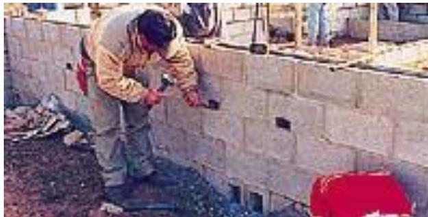
Le mortier de remplissage est un mélange fluide qui a comme finalité de solidariser les ferrillages dans le mur, remplissant les trous ferrillés.
