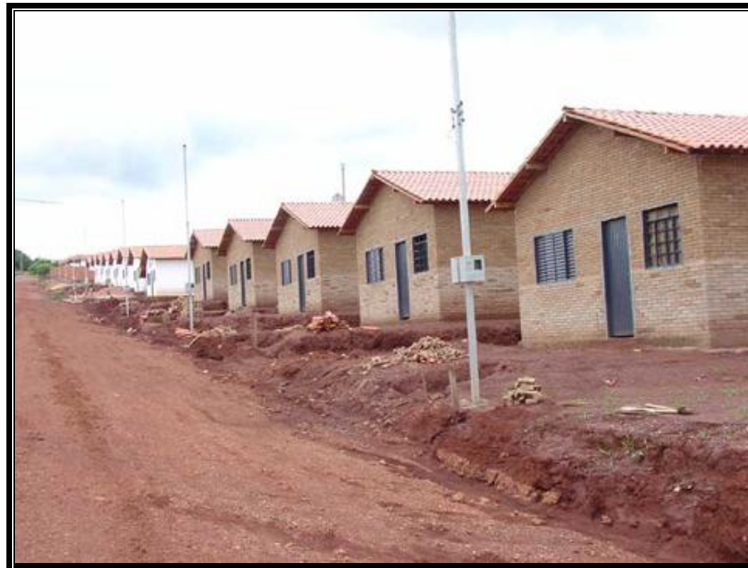
OUVRAGE en Afrique – URBANISATION - STABIBLOCK' System REALIZACION en Africa – URBANIZACIÓN - STABIBLOCK' System
