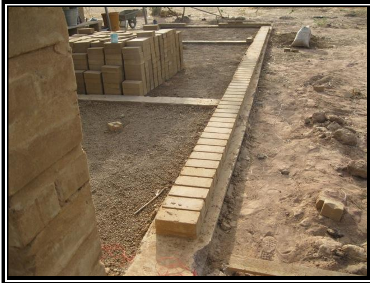
Les FONDATIONS en BRIQUES Pleines
