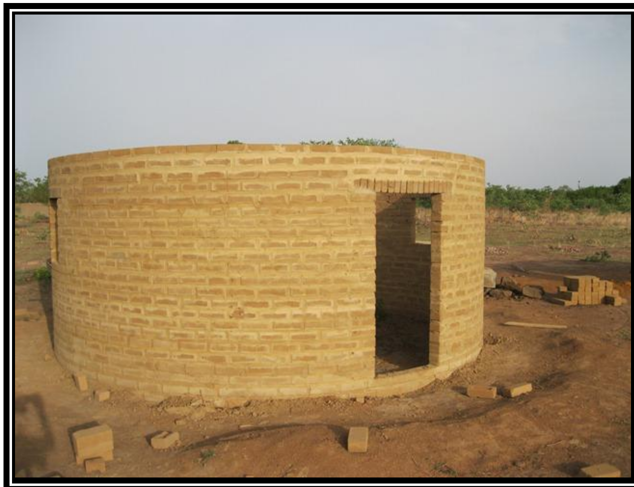
RÉALISATION en BRIQUES Pleines
