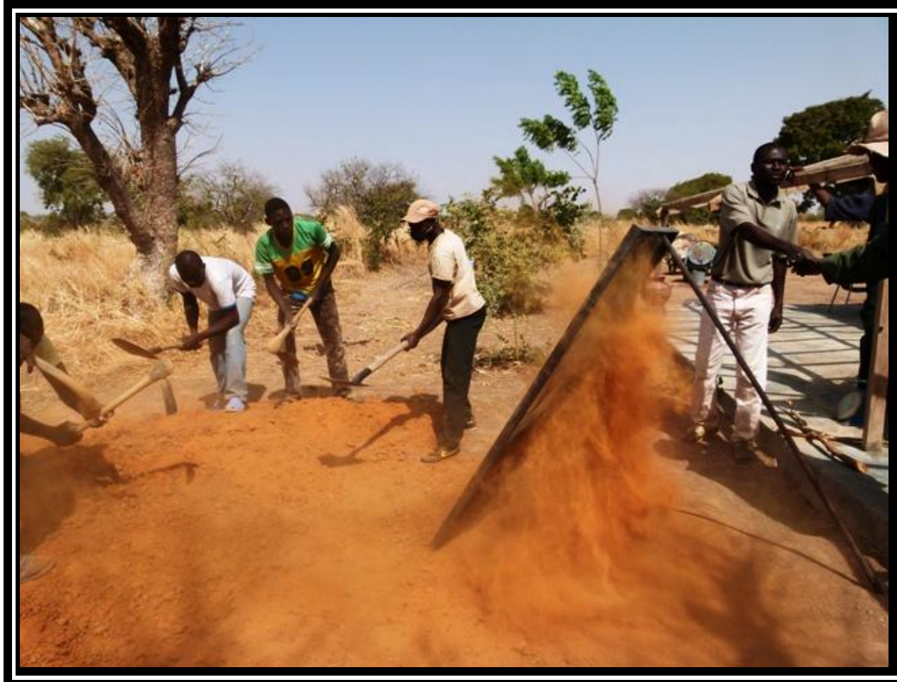
CRIBLAGE de la TERRE Latérite
